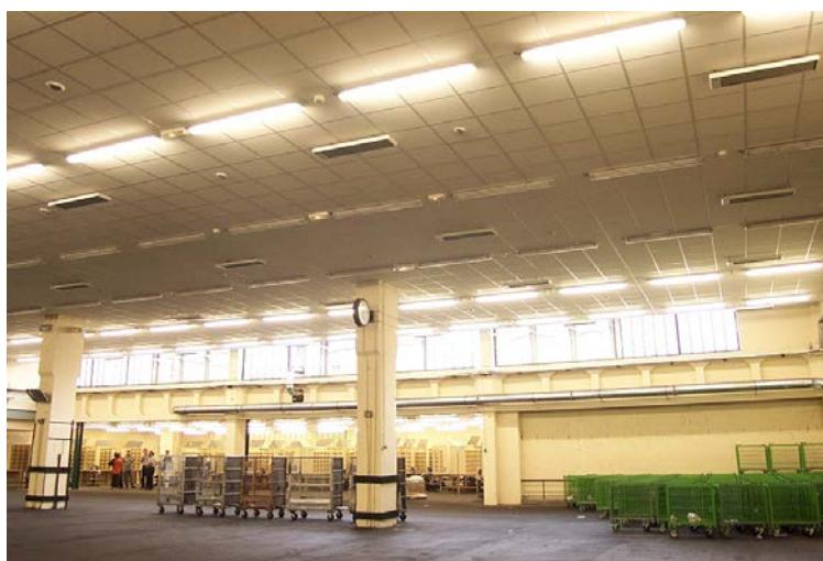
Инфракрасное излучение от приборов поглощается элементами помещения, мебелью и телом человека. Это обеспечивает комфортность обогрева даже для помещений большого объема.
