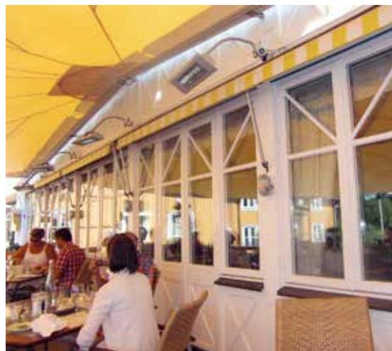
При использовании специальной штанги высота расположения самого прибора находится ниже относительно места крепления скобы на стене.
