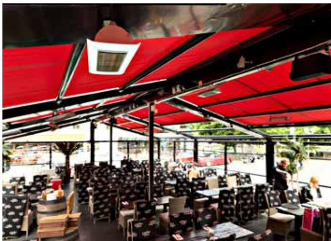
Карбоновый инфракрасный обогреватель создает интенсивный тепловой поток, однако яркость его нагревательного элемента значительно ниже, чем у его аналога с галагеновой лампой.
